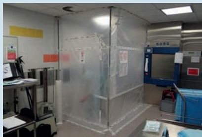
Abbildung 10: Schaffung eines Arbeitsbereiches (Staubschutzwand) (Quelle: Firma Henkel Beiz- und Elektropolieretechnik)
