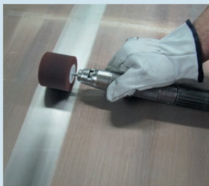
Abbildung 12a: Mechanische Sanierungsmaßnahmen (Quelle: Firma MMM)
